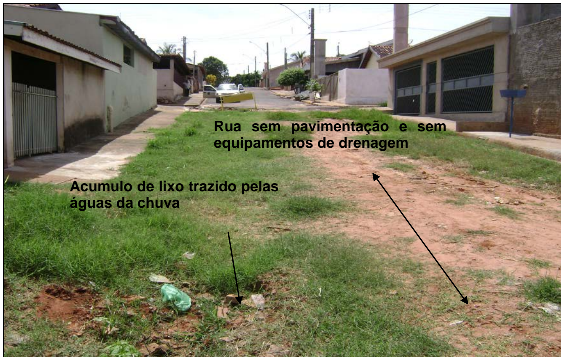
Foto 4. Rua sem pavimentação e sem equipamentos de drenagem, causando transtorno aos moradores devido acúmulo de lixo trazido pelas águas das chuvas
