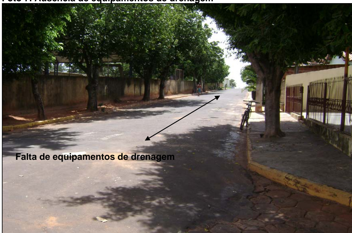
Foto 7. Ausência de equipamentos de drenagem
