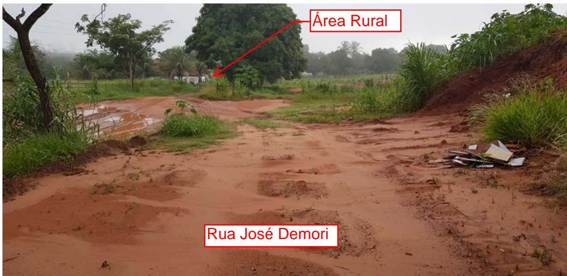
Prolongamento da Rua José Demori após dias de precipitações.
