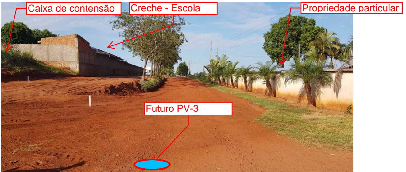
Prolongamento da Rua José Demori - Sentido Área Rural - Cidade
