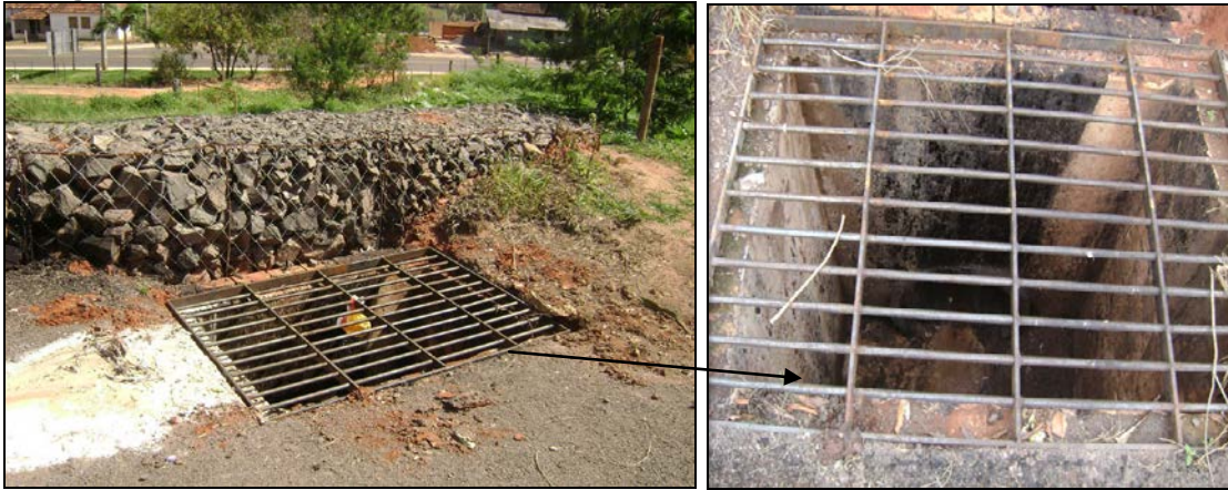
Fotos 17 e 18. Muro de arrimo com gabiões e caixa de queda para recolhimento da água pluvial na parte baixa do desnível
