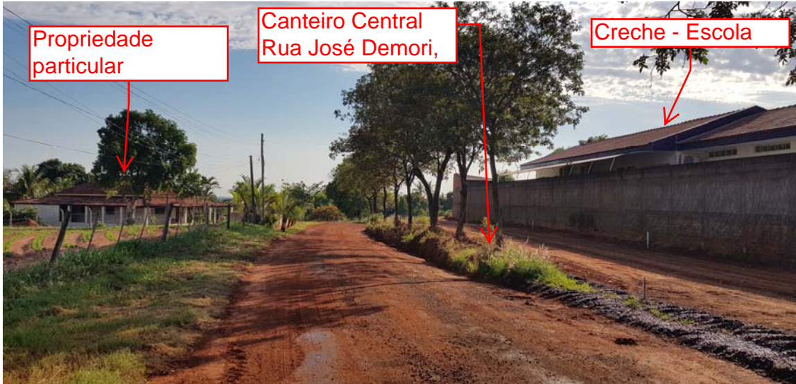
Prolongamento da Rua José Demori – Sentido Cidade – Área Rural
