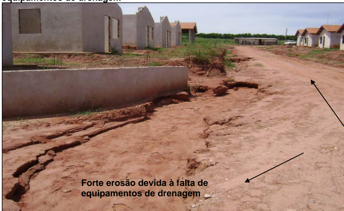
Foto 8. Rua sem pavimentação e sem qualquer tipo de implantação de equipamentos de drenagem
