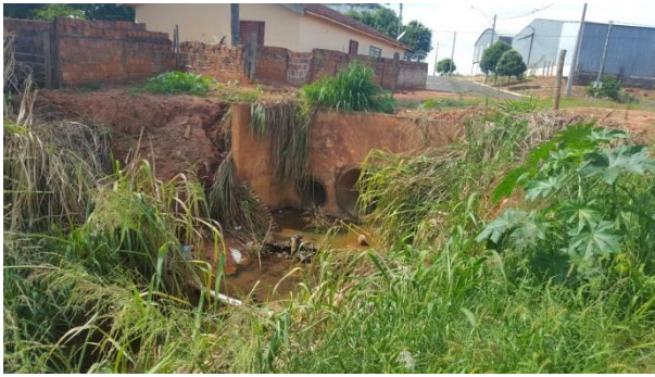
Foto 3.1 – Galeria na Rua Ângelo Sanches Parra
