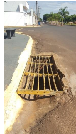
Foto 3.2- Boca de lobo Rua José Demori
